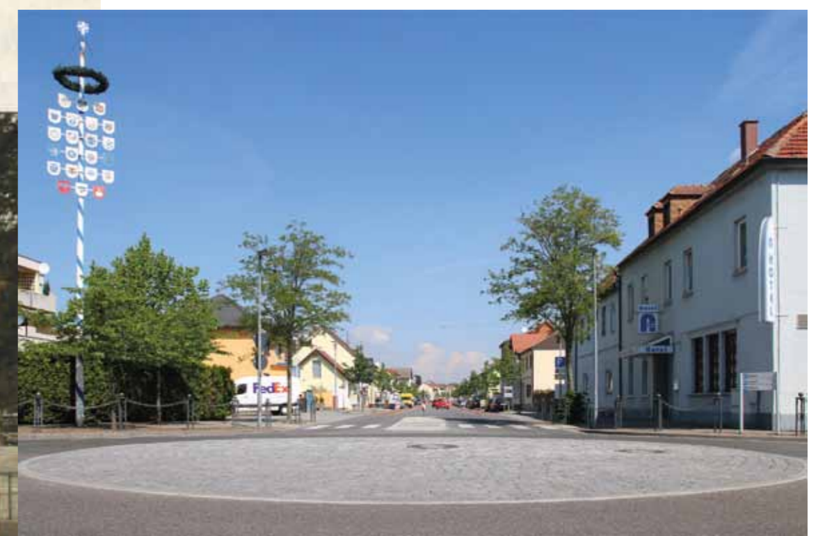
Minikreisel in der Ortsmitte nach der Fertigstellung.
